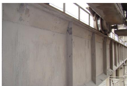
Рисунок 9 – Подкрановая балка по ряду А в осях 2–3
