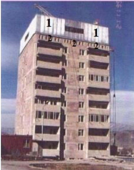
Рисунок 3 – Примеры реализации динамических гасителей в зданиях, построенных в Армении [7]: а – 9-этажное здание в г. Ванadzоре с изолированным верхним этажом (автор М. Мелкумян), 1 – изолированный этаж; 2 – подушки; б – 12-этажное здание в г. Ереване с гасителем сейсмических колебаний (автор З. Хлгатыян), 1 – междуэтажные перекрытия; 2 – подушки
