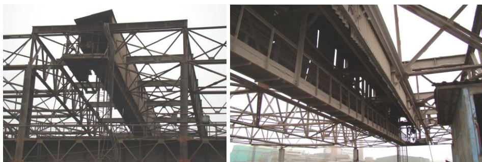
Рисунок 8 – Ремонтный загон в осях 5–4
