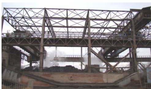
Рисунок 7 – Часть сохранившейся кирпичной стены вдоль ряда Б (оси 1–4)
