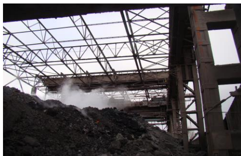
Рисунок 4 – Вертикальные и горизонтальные связи между стропильными фермами (вид от оси 1)
