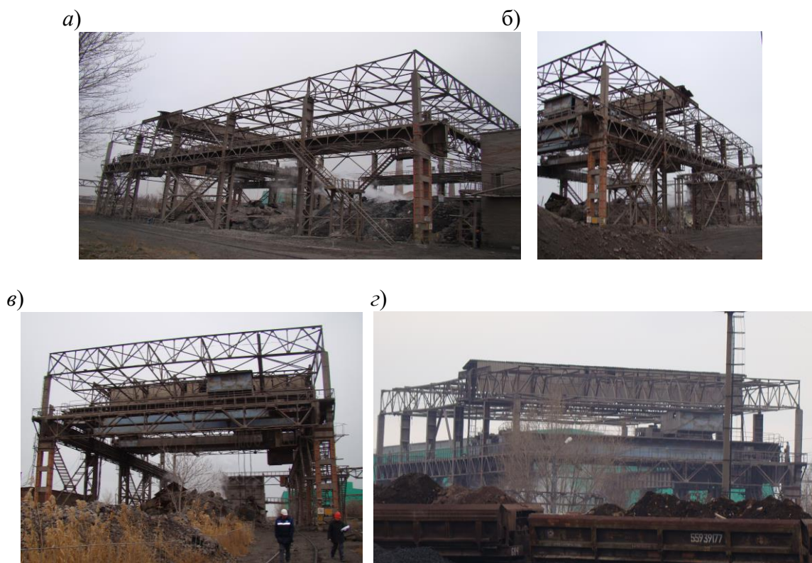
Рисунок 1 – Вид эстакады шлакового двора мартеновского цеха
