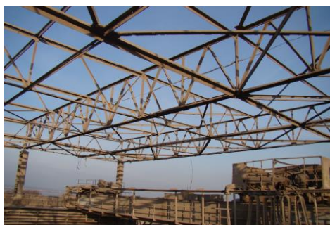
Рисунок 3 – Стропильные фермы по осям 1 и 2
