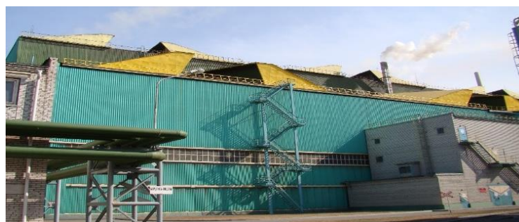
Рисунок 2 – Здание ОНЛЗ со стороны ряда В
