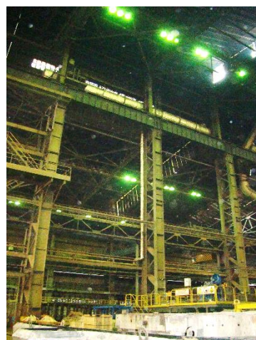
Рисунок 4 – Колонна по ряду А с кронштейном (а), по ряду В (б) и вертикальная связь между колоннами по ряду В (в)
