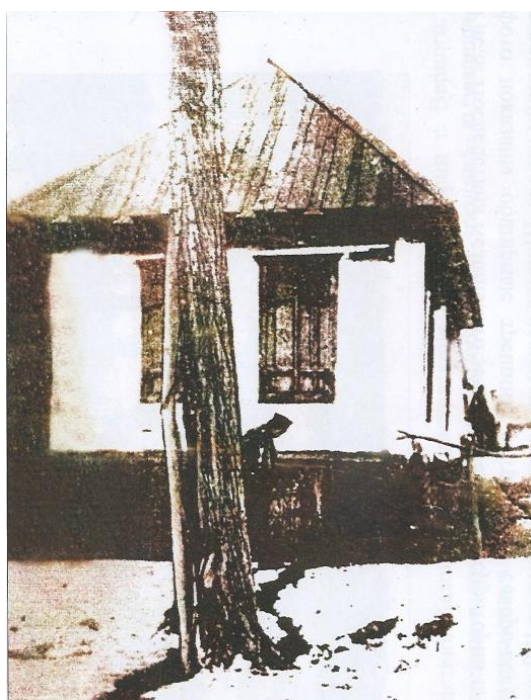
Рисунок 6 – Последствия Кеминского землетрясения на территории г. Верный. На фото показано дерево диаметром до 0.5 м, разорванное вдоль на высоту до 3.5 м трещиной, образовавшейся в грунте
