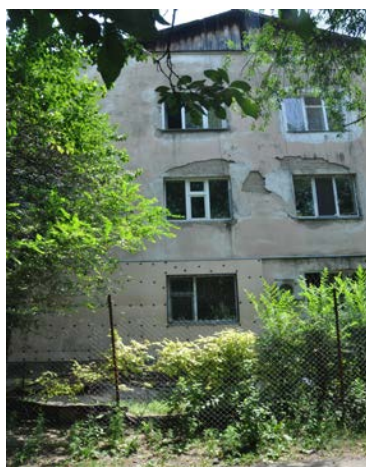
Рисунок 3 – Кирпичное здание, ул. Щербакова, дом 16 Figure 3 - Brick building, 16, Shcherbakov St.
