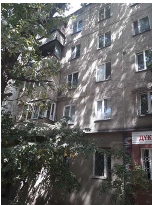
Рисунок 2 – Крупнопанельное здание с первым гибким этажом, ул. Мынбаева, дом 47
