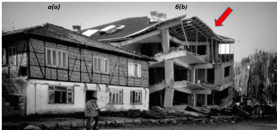
Рисунок 14 – Два здания в г. Дюздже, Турция, после землетрясения в ноябре 1999 г.: a – здание «hımış» с деревянным каркасом и каменным заполнением; б – здание с железобетонным каркасом
