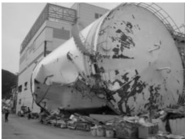
Рисунок 7 – Опрокинутый цунами резервуар. Япония, 2011 г. [10]
