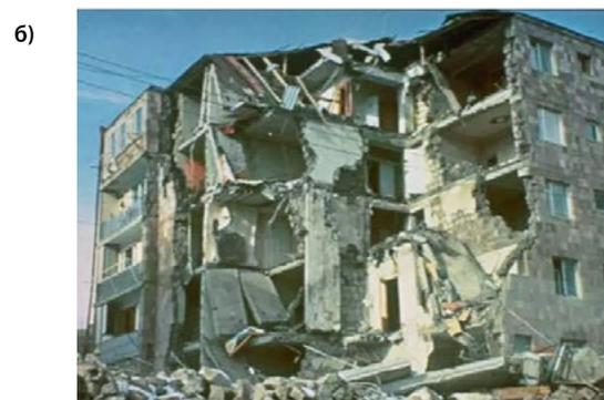
**Рисунок 5.2** — а, б – Разрушение каменных зданий во время Спитакского землетрясения 7 декабря 1988 г.
