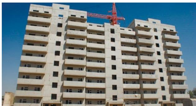
В Узбекистане стартовали вибродинамические испытания крупнопанельного 9-этажного дома. Экспериментальные испытания на сейсмостойкость новой конструктивной схемы, которую планируют ввести в серийное производство по программе «Доступное жилье в Узбекистане», проводят специалисты Казахского научно-исследовательского и проектного института строительства и архитектуры (АО «КазНИИСА»).
