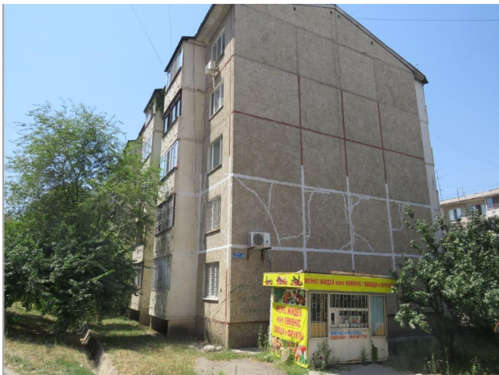
Рисунок 5 – Мкр. Мамыр-2, дом 15 (сейсмостойкий дом)
