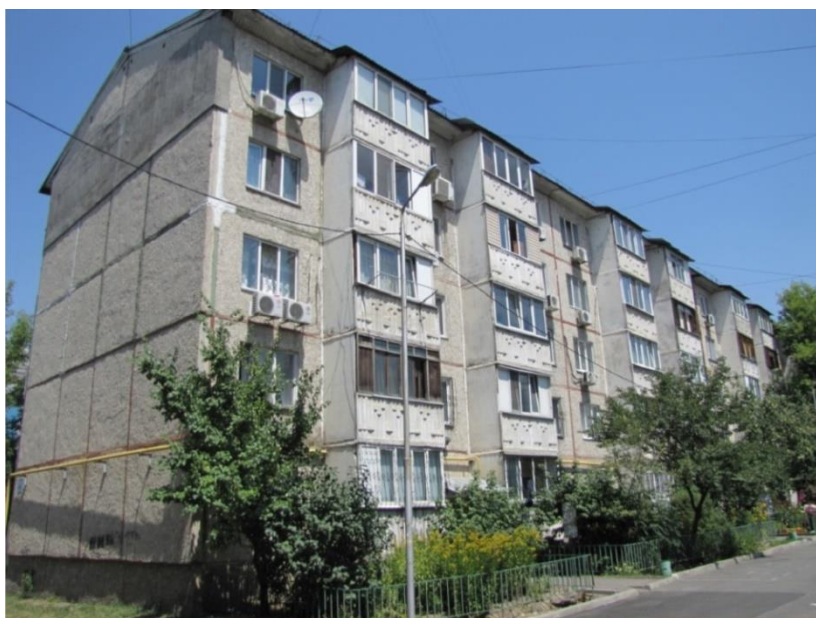
Рисунок 4 – Мкр. Мамыр-1, дом 9 (сейсмостойкий дом)
