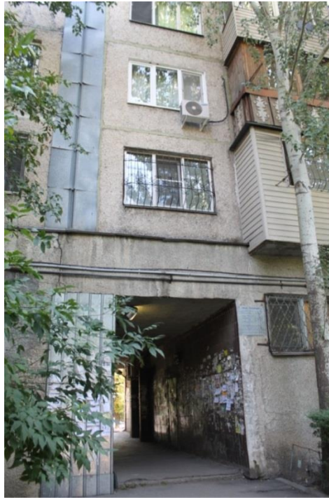
Рисунок 1 – Ул. Ауэзова, дом 65 (сейсмоопасный дом)
