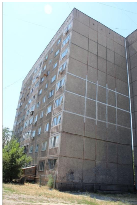
Рисунок 7 – Мкр. Тастак-1, дом 11 (сейсмостойкий дом)
