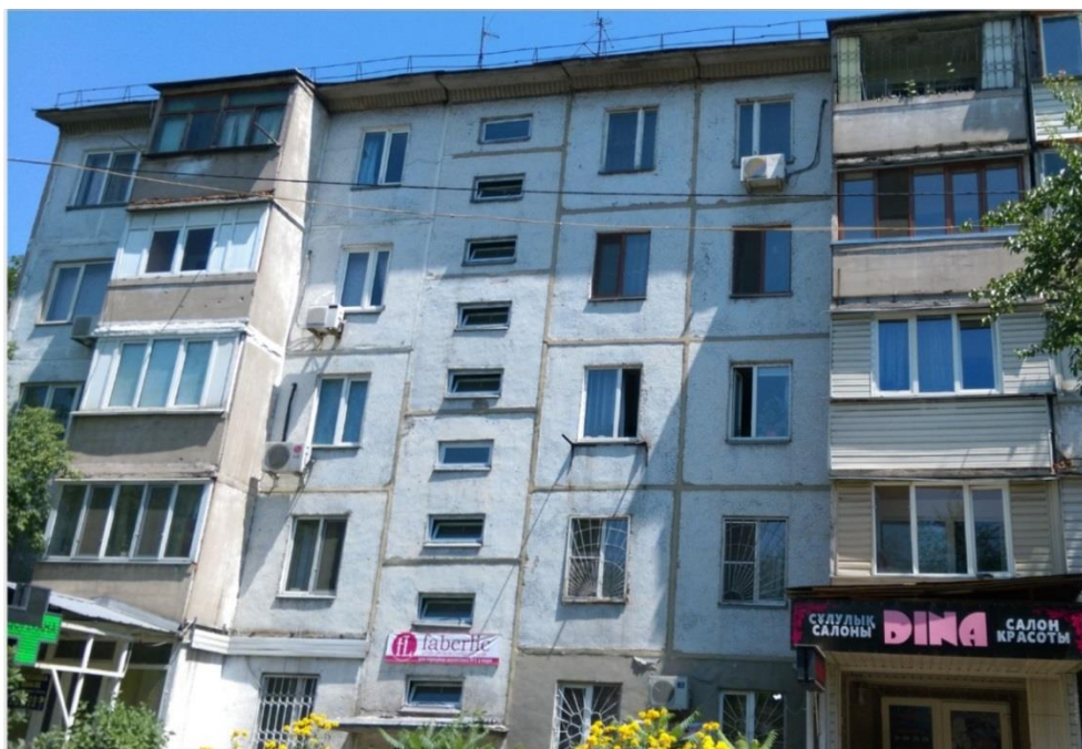
Рисунок 6 – Мкр. Тастак-1, дом 6 (сейсмостойкий дом)
