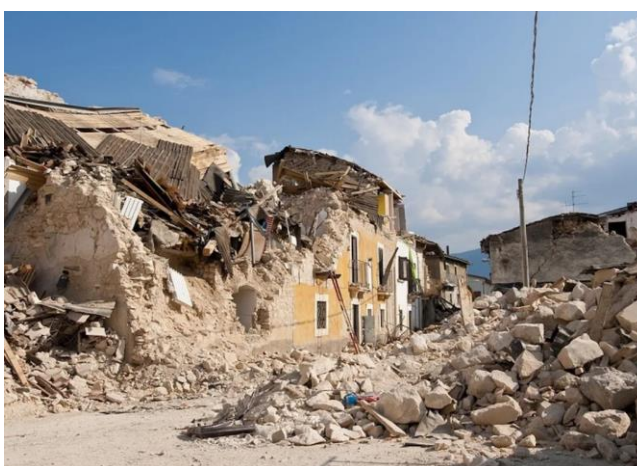
Рисунок 1 – Разрушение зданий при землетрясении в Индонезии (2021 г.)
