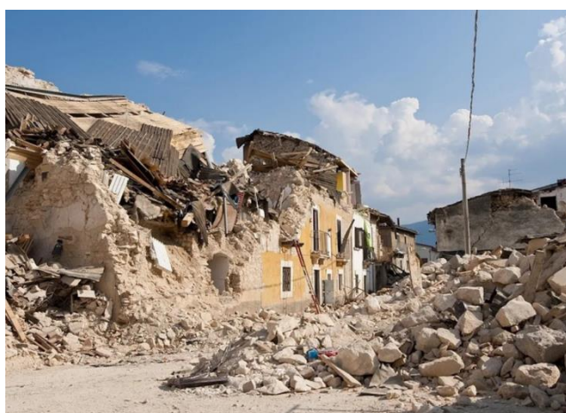
Рисунок 1 – Разрушение зданий при землетрясении в Индонезии (2021 г.)
