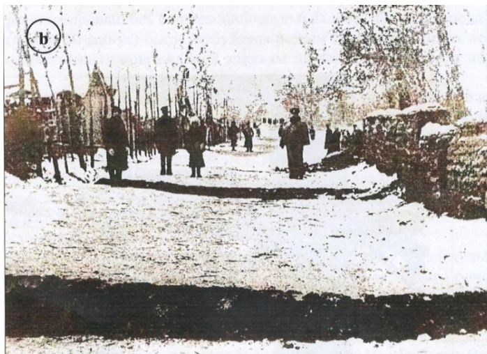
Рисунок 2 – Последствия Кеминского землетрясения на территории г. Верный. На фото показаны обширные трещины в грунте в северо-восточной части территории города. Ширина раскрытия трещин достигает 100 см, а глубина в отдельных случаях до 500 см.
