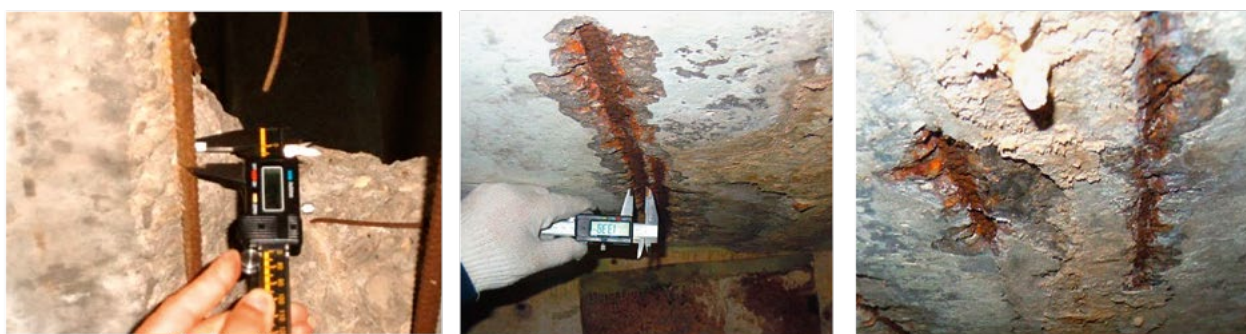
Рисунок 2 — Измерение остаточного диаметра рабочей арматуры железобетонной плиты Figure 2 — Measurement of residual diameter of reinforced concrete slab working reinforcement
